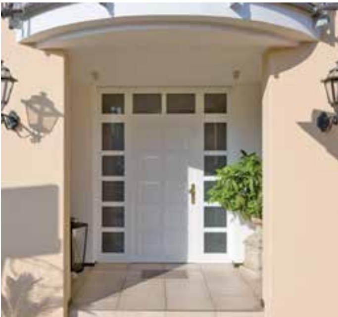
Objekt, Büren z. Hof
